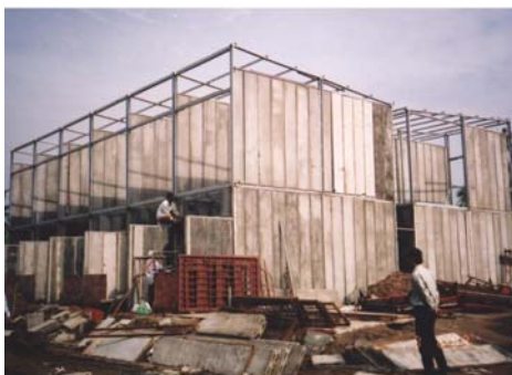
Hình 9 : Thi công lắp dựng nhà
