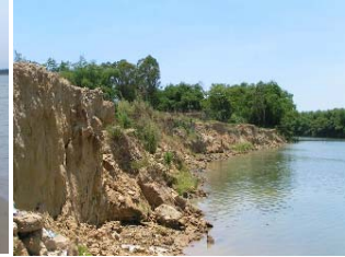
A4. Xói lở do dòng chảy dồn vào sông nhánh Vĩnh Điện (Điện An) trên đoạn bờ dài hơn 1km (5/2005)
