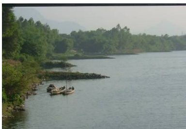
A5. Xói lở bờ lồm tại Nam Câu Lâu đã được xây dựng kè mỏ hàn năm 95-96, đang phát huy tác dụng tốt. (2003)
