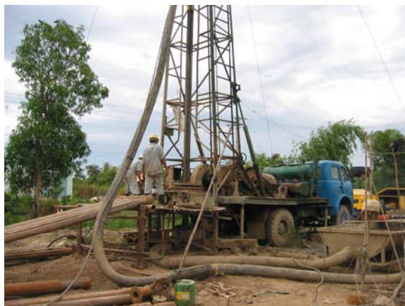
Hình 4: Máy khoan YPB-3AM-500 đã cải tạo thi công giếng khoan Sa Đéc.
