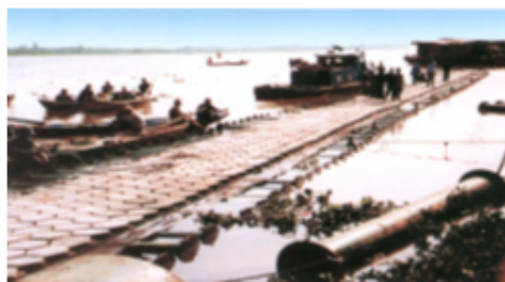
Thi công lắp ghép lưới thảm P.Đ.TAC-M
