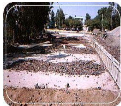
Hình 6: Chuẩn bị nền đường
