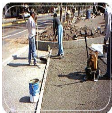
Hình 7: Thi công đầm rung
