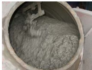
Hình 13: Trộn hỗn hợp bê tông tươi
