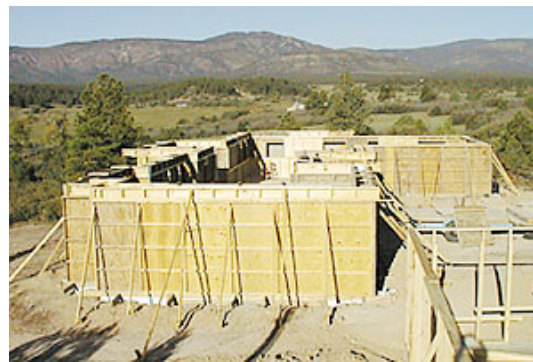
Hình 4: Lắp khuôn để thi công tường bao che
